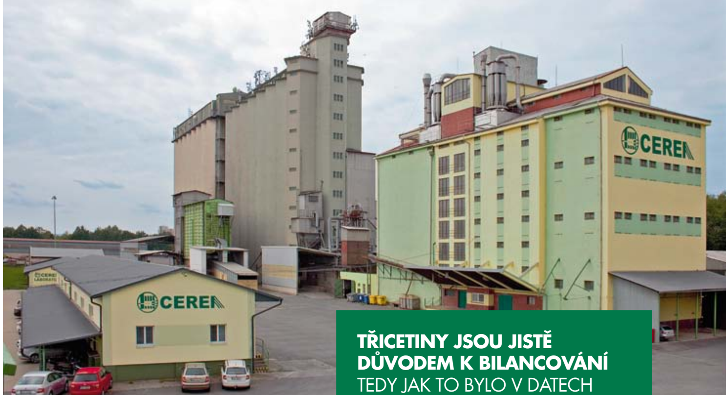
Centrála, pohled na silo a centrální spisovnu
