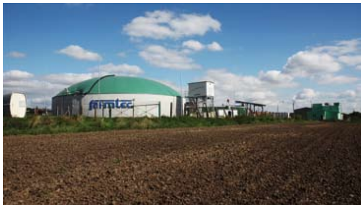
Bioplynová stanice FARMTEC s výkonem 558 kW se nachází nedaleko Prostějova ve Vrahovicích. Stanice má fermentory kruh v kruhu s integrovaným plynemem na koncové jímce a kogenerační jednotku GE, která je umístěna v budově. Substrátová skladba: kukuřičná siláž, cukrovarské řízky, hnůj, senáž, vepřová a hovězí kejda.
