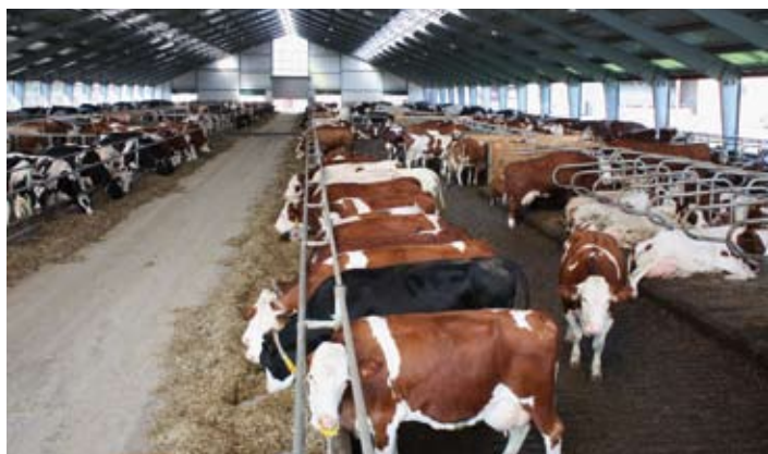
Novostavba roštové stáje pro 450 dojnic ve Zdislavicích, lehací boxy jsou vybaveny měkkými gumovými matracemi. Konstrukce haly je ocelová bezsloupová, zastřešená sendvičovým panelem plech/pur/sklolaminát s hřebenovou větrací štrbinou.
