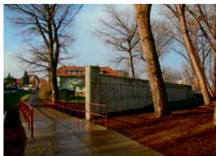
Nová část protipovodňové ochrany u břehu Modly
