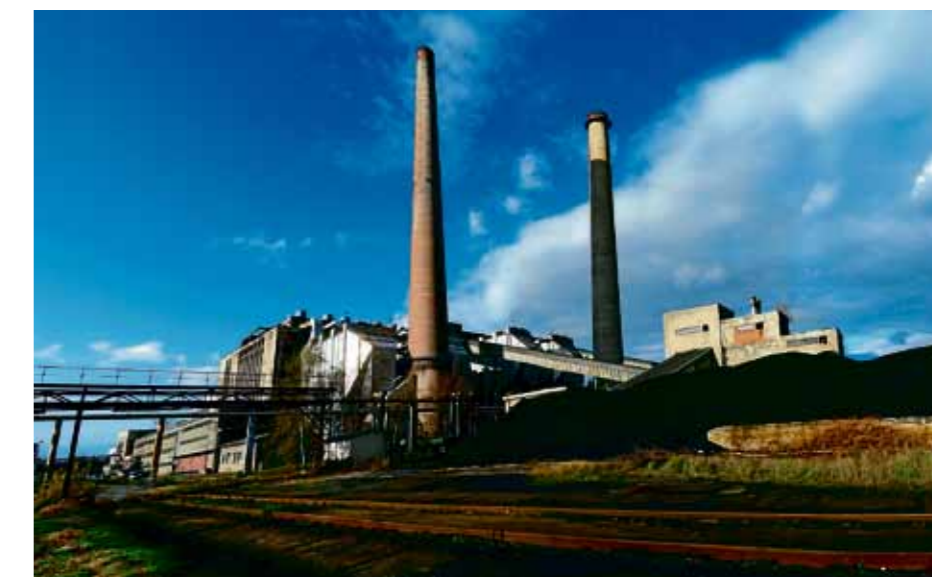
Významný investiční projekt společnosti Synthesia se týká rekonstrukce teplárny.
