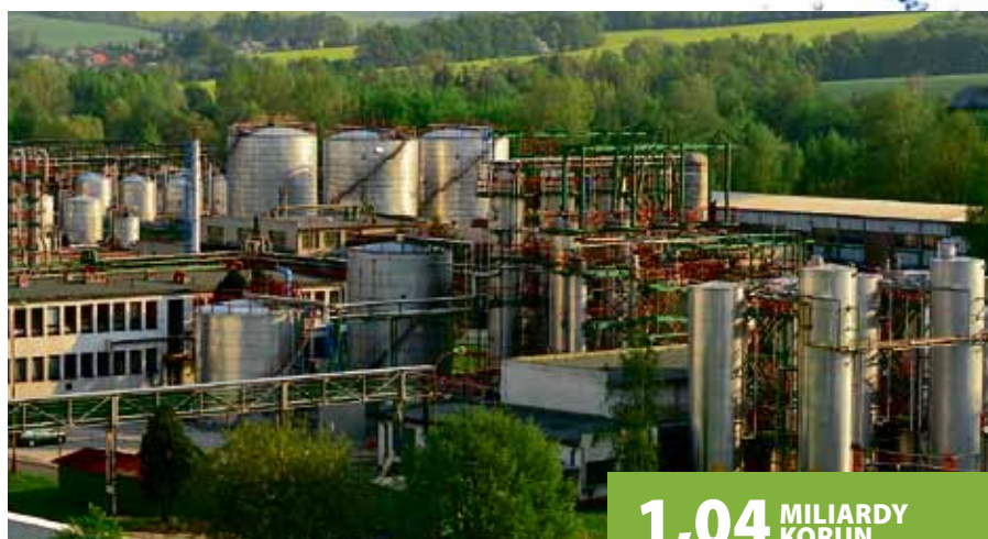
Nově vybudovaná čistírka odpadních vod ve společnosti Synthesia
