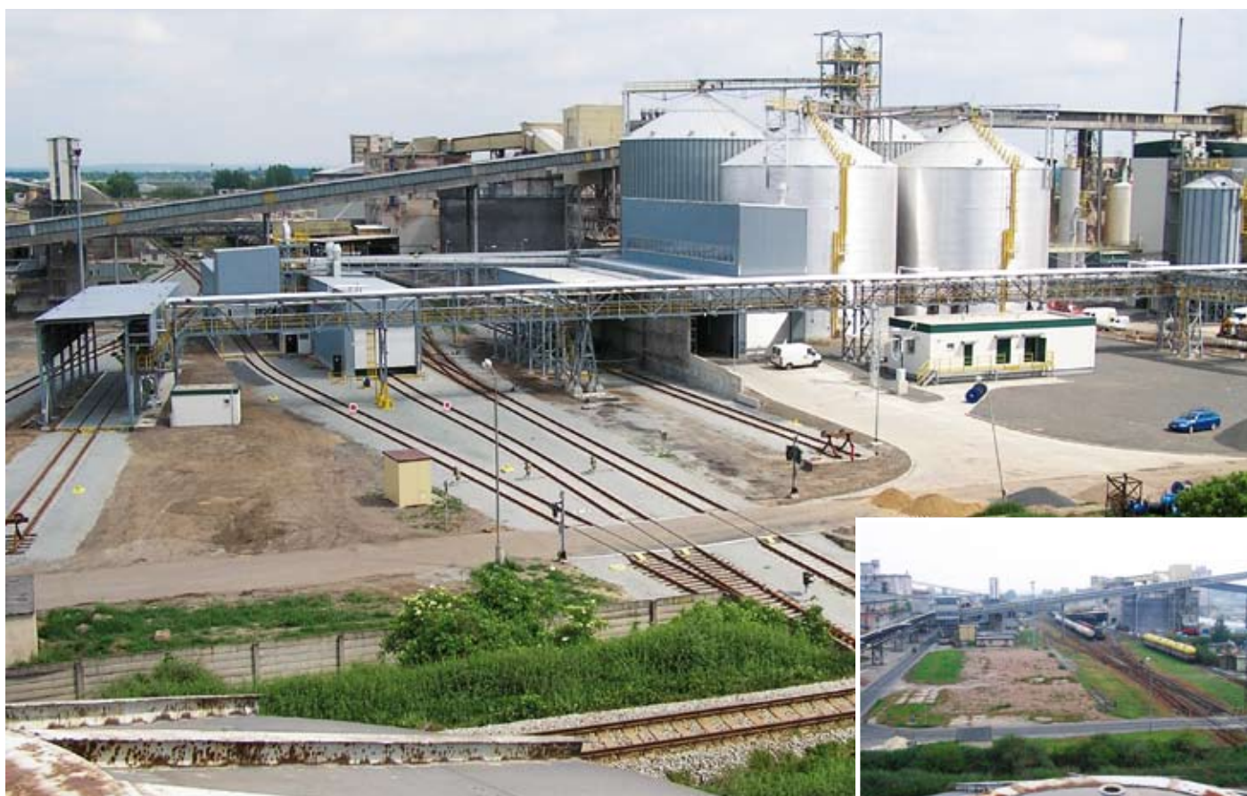
Rozdíl mezi starou a novou vlečkou je patrný na první pohled
