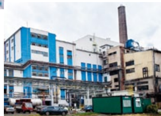
Ekologizace energetického zdroje v Lovochemii. Východním bodem kompletní modernizace byla náhrada zastaralých uhelných práškových kotlů.
